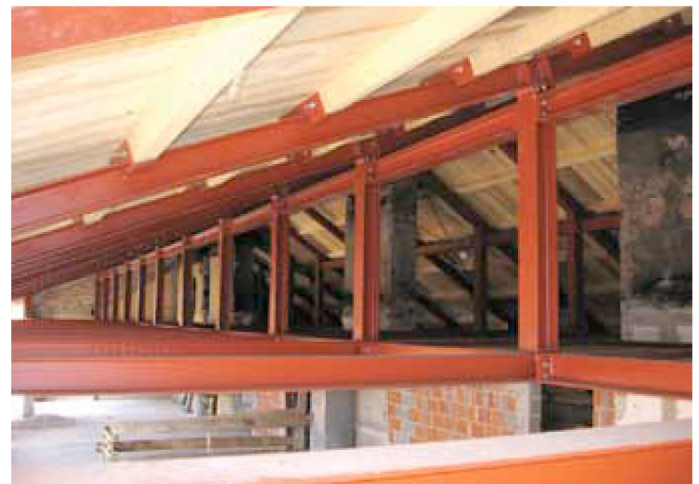
Podstrešje z utrjeno etažno konstrukcijo, novimi zidovi in vezmi ter jekleno konstrukcijo ostrešja.
