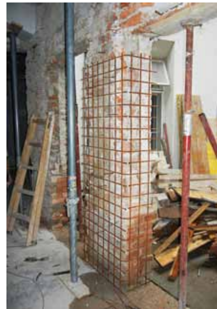
Izvedba armiranobetonskega ometa opečnega slopa
