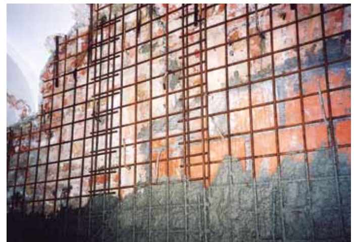
Izvedba armiranobetonskega ometa opečnega zidu
