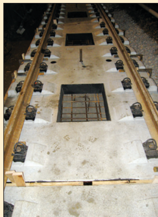
ÖBB-PORR plošče po vgradnji v predoru Križiški in betonska plošča (vir ZRMK)
