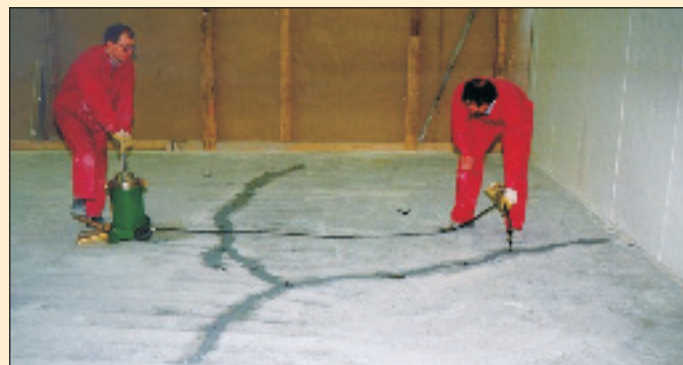
Zapiranje in tesnjenje manjših reg, razpok in por pri prodoru vode in drugih kapljev
