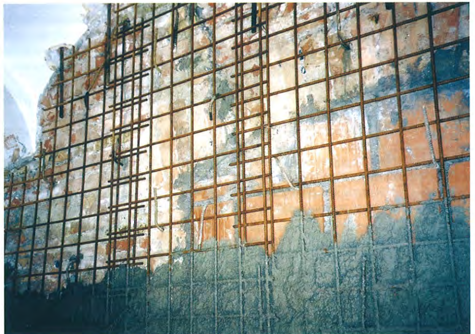
Slika 4 • Izvedba obojestranskih armiranih ometov opečnih zidov
