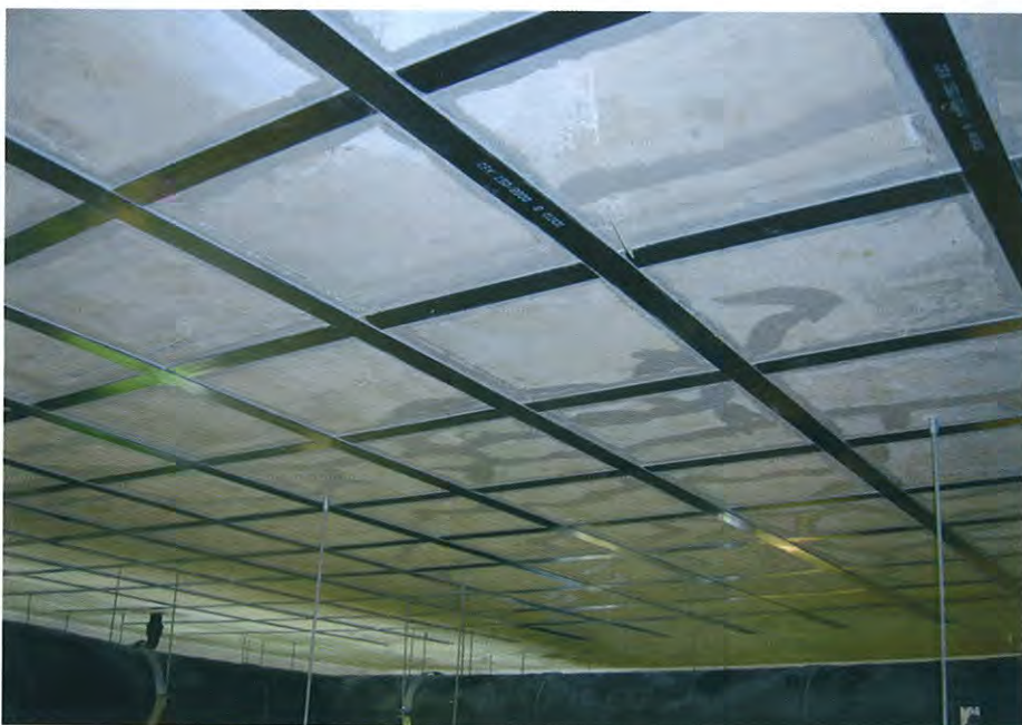
Slika 9 • Povečanje nosilnosti armiranobetonske plošče s karbonskimi lamelami
