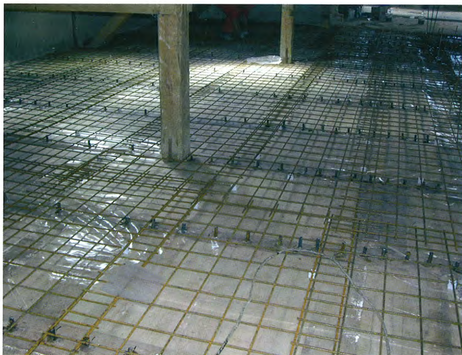
Slika 6 • Izvedba armiranobetonskega sovprežnega estriha: opaž med stropniki, folija, armaturne mreže, v stropnike vgrajeni mozniki, še distančniki, pa bo pripravljeno za betoniranje
