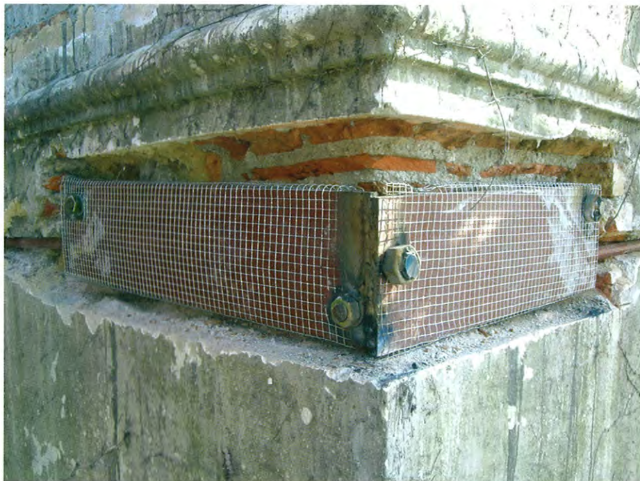
Slika 5 • Izvedba protipotresnih zidnih vezi: sidrni plošči na vogalu sta obdani z rabitz mrežo za ojačitev ometa, matice so točkovno privarjene, vsi elementi pa so protikorozijsko zaščiteni
