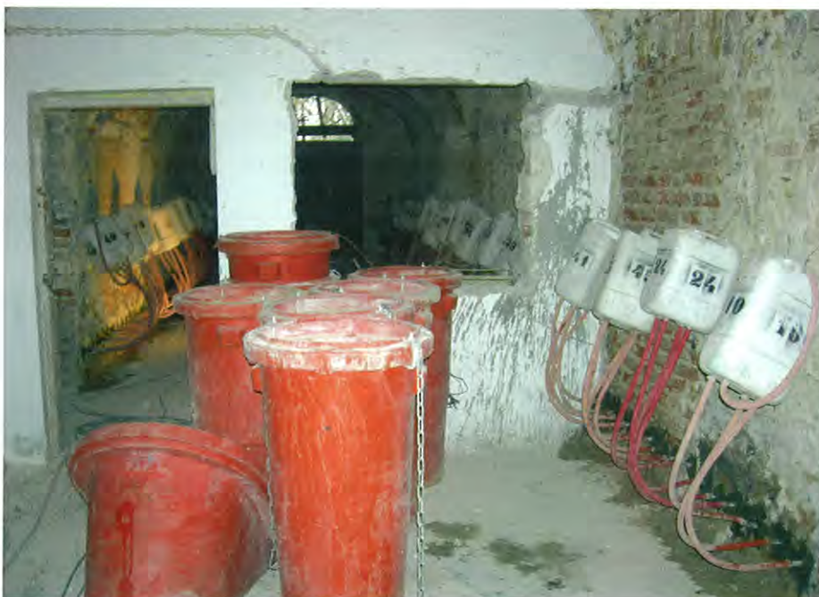
Slika 10 • Izvedba hidrofobne barriere z raztopino silikonov
