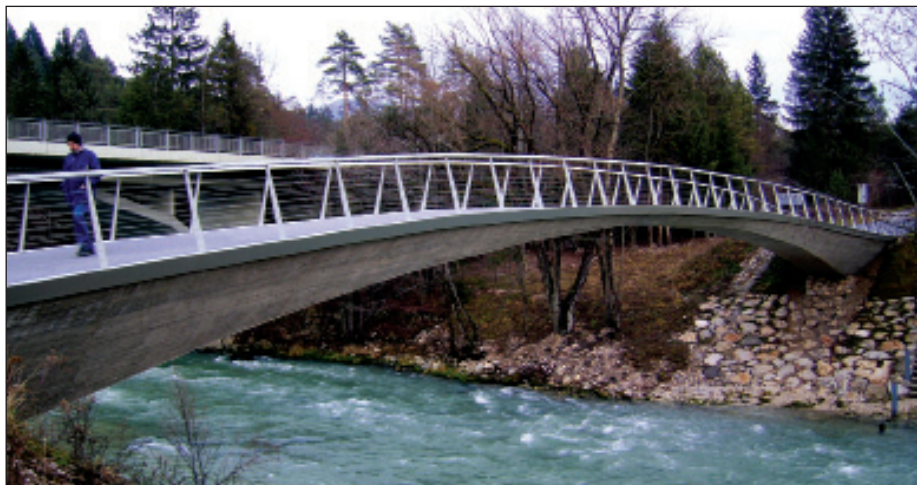
Brv čez kanjon Save pri Radovljici. Brv je zasnovana tako, da kljub betonski konstrukciji deluje čim bolj lahkotno. Avtor arhitekture je mag. Peter Gabrijelčič, univ. dipl. inž. arh., avtor statike pa Peter Koren, univ. dipl. inž. grad.
